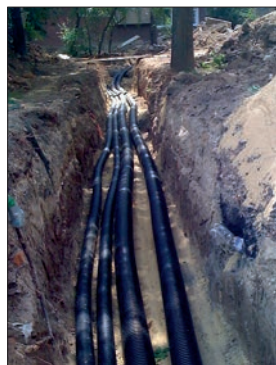
Abb. 2: Verlegung im Sandbett
